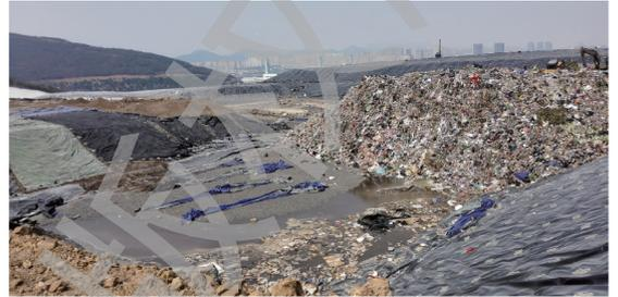
图1 某垃圾填埋场固化飞灰与生活垃圾混合填埋
